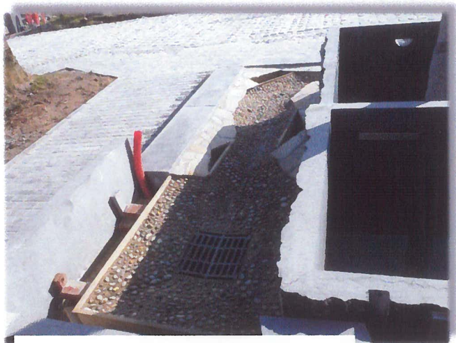
La réalisation du chenal avec ses chicanes et jardinières pour plantes d'eau...
